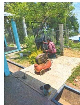
Foto 4: Sustitución a portón de ingreso, material: metálico, incluye: bisagras y sistemas de cierre.
