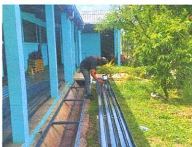
Foto 5: Reparación de cuneta de concreto, rejilla metálica.
