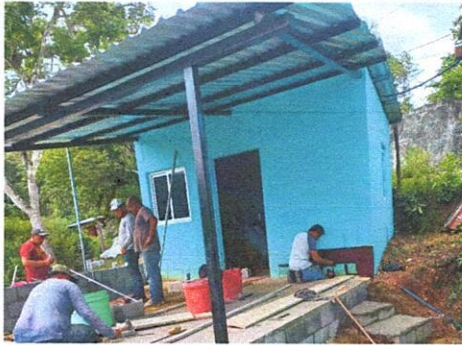
Foto1: Sustitución de cubierta de techo con lámina galvanizada, Tipo de lámina: troquelada Calibre: 26, incluye: fijaciones y sellado en traslapes.
