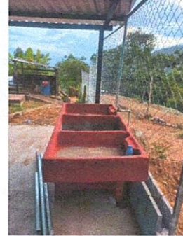
Foto 2: Sustitución pila, nivelada y con conexiones hidráulicas.
